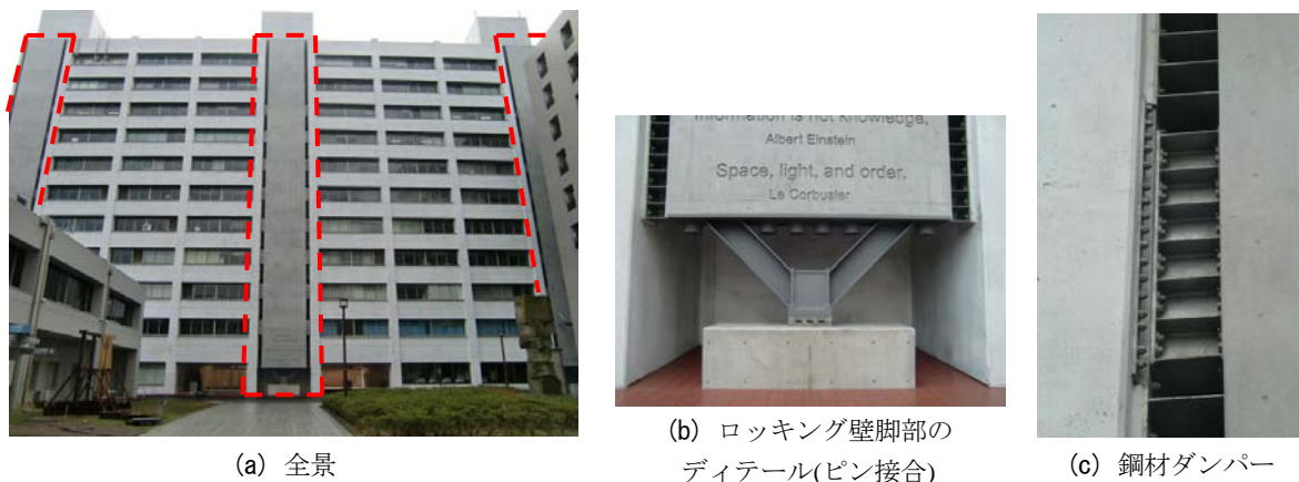
図 1 東京工業大学すずかけ台キャンパスにおける RW 耐震改修事例 (G3 棟)
